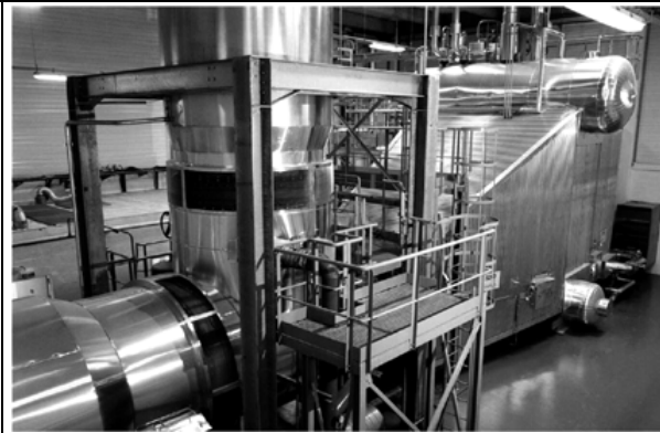
Figure 8.3.3: Cogeneration HRSG, Documentation SECC
